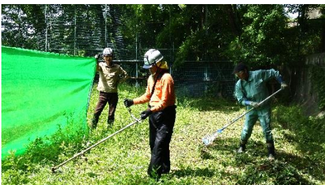
飛散防止ネットを使い安全にも留意
